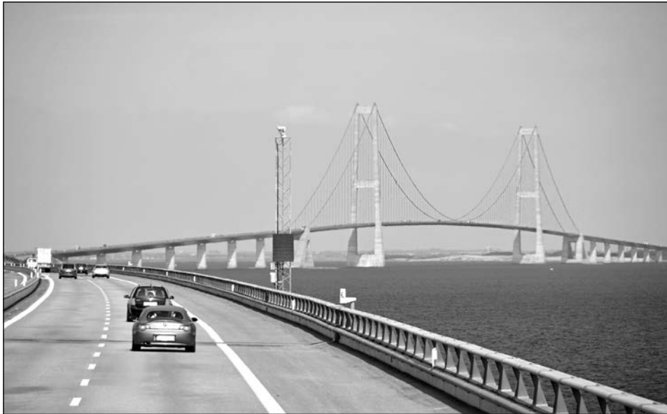
Abb. 3: Brücke über den Großen Belt (Foto: H. Loose)
