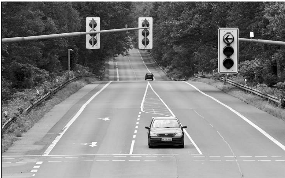
Abb. 10: Bergsenkungsmulde entlang der Münsterstraße in Gelsenkirchen, im Vergleich zu 1892 hat sich das ursprünglich ebene Gelände um mindestens 19 m abgesenkt (Foto: S. Harnischmacher)
