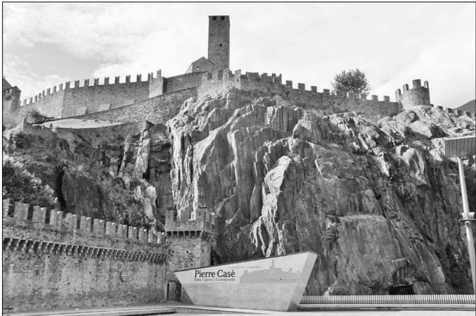
Abb. 11: Blick auf die befestigte Anhöhe des Castelgrande in Bellinzona (Foto: J. Benz)
