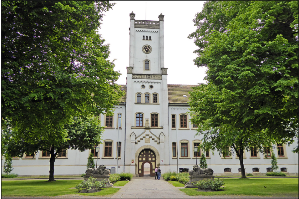
Abb. 5: Schloss Aurich (Foto: H. Loose)
